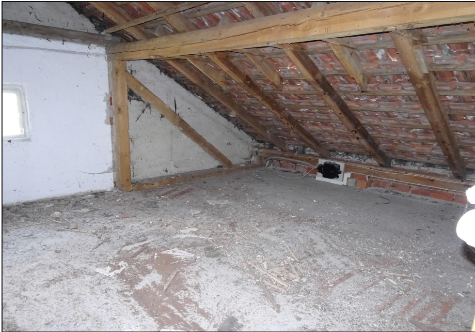
Abbildung 5 Dachraums im Abrissgebäude
